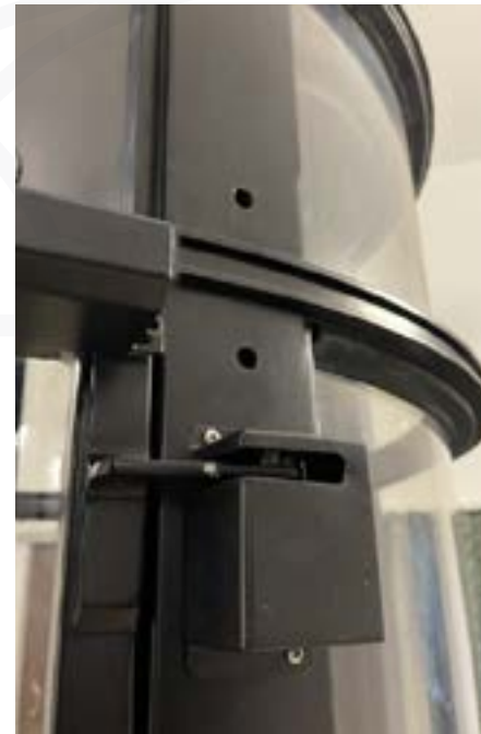
Siri II LUBANG PENYAMBUNG TERLIHAT PADA SEMUA TIANG
